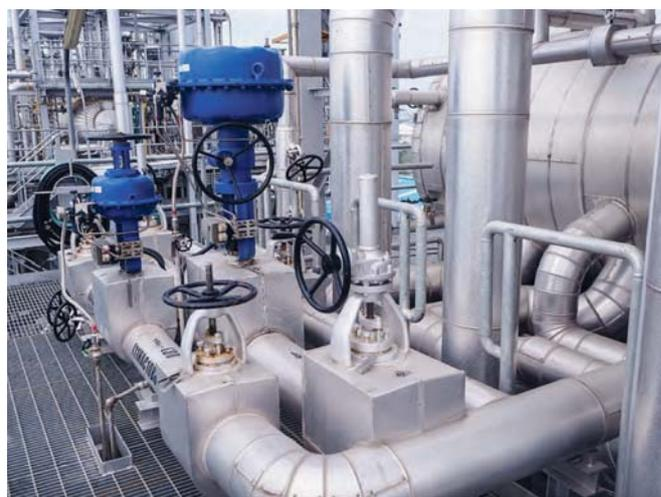
на входе и заданном ходе регулирующего элемента объем потока остается постоянным независимо от изменений давления на выходе.
